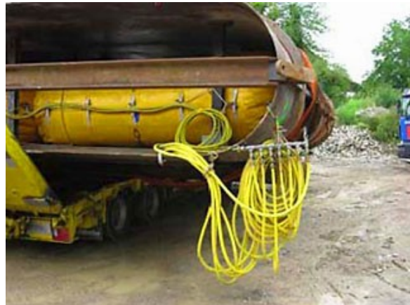
Auftriebskörper in Schalung montiert
