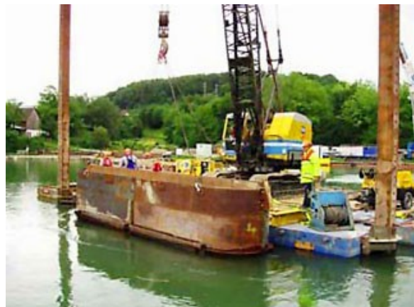
Schalung in Position gebracht
