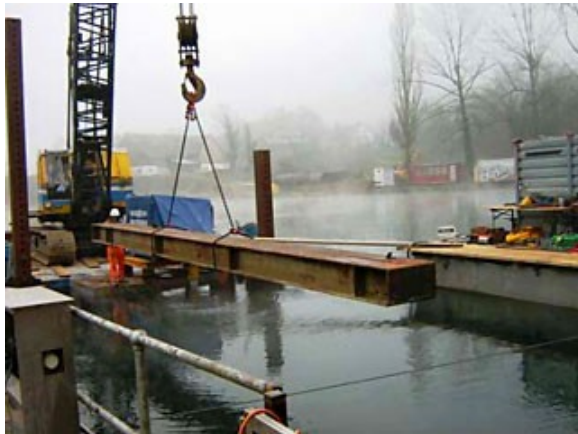
Versetzen der Spundwand
