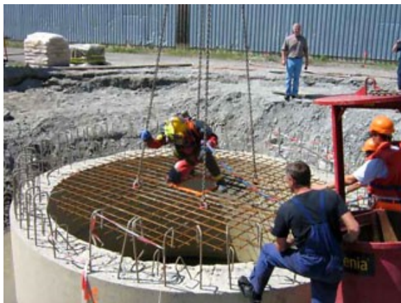
Absenken der Armierung
