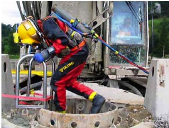
Einstieg von Franz Hattan in das Bohrrohr Ø 90 cm
