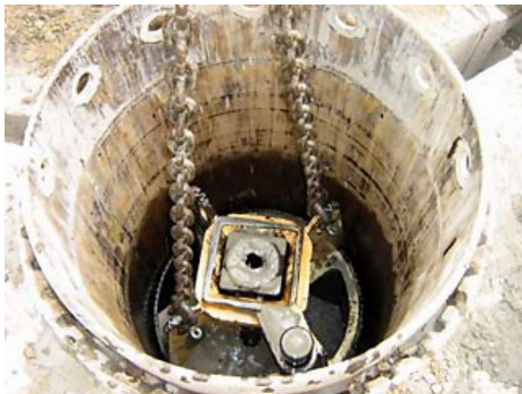
Heben des Bohreimers
