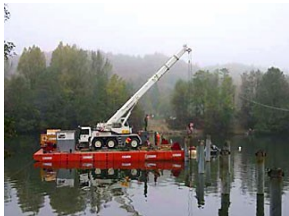
Autokran auf schwimmender Arbeitsplattform (Ponton)
