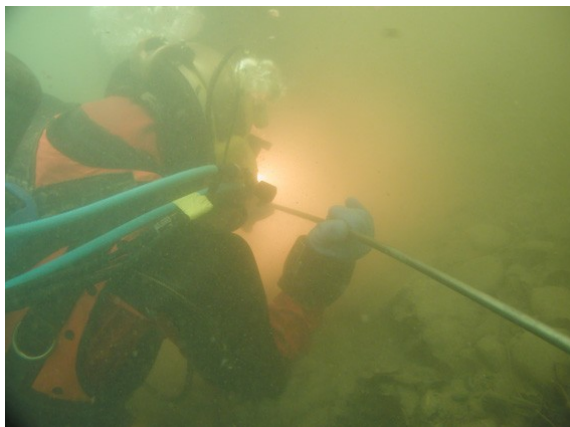
Franz Hattan beim Abtrennen der Brückenpfeiler am Aaregrund
